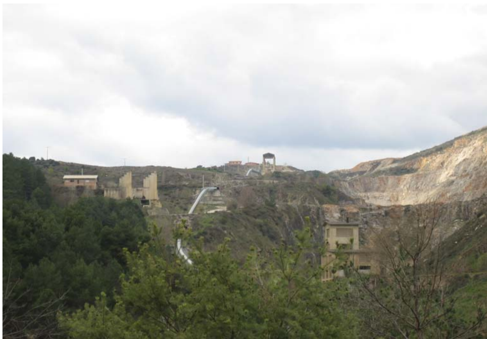
Figura 28.- Vista panorámica de la explotación “Cosmos I”: planta de tratamiento, cinta transportadora y frente superior de la cantera, con sus respectivos bancos.
